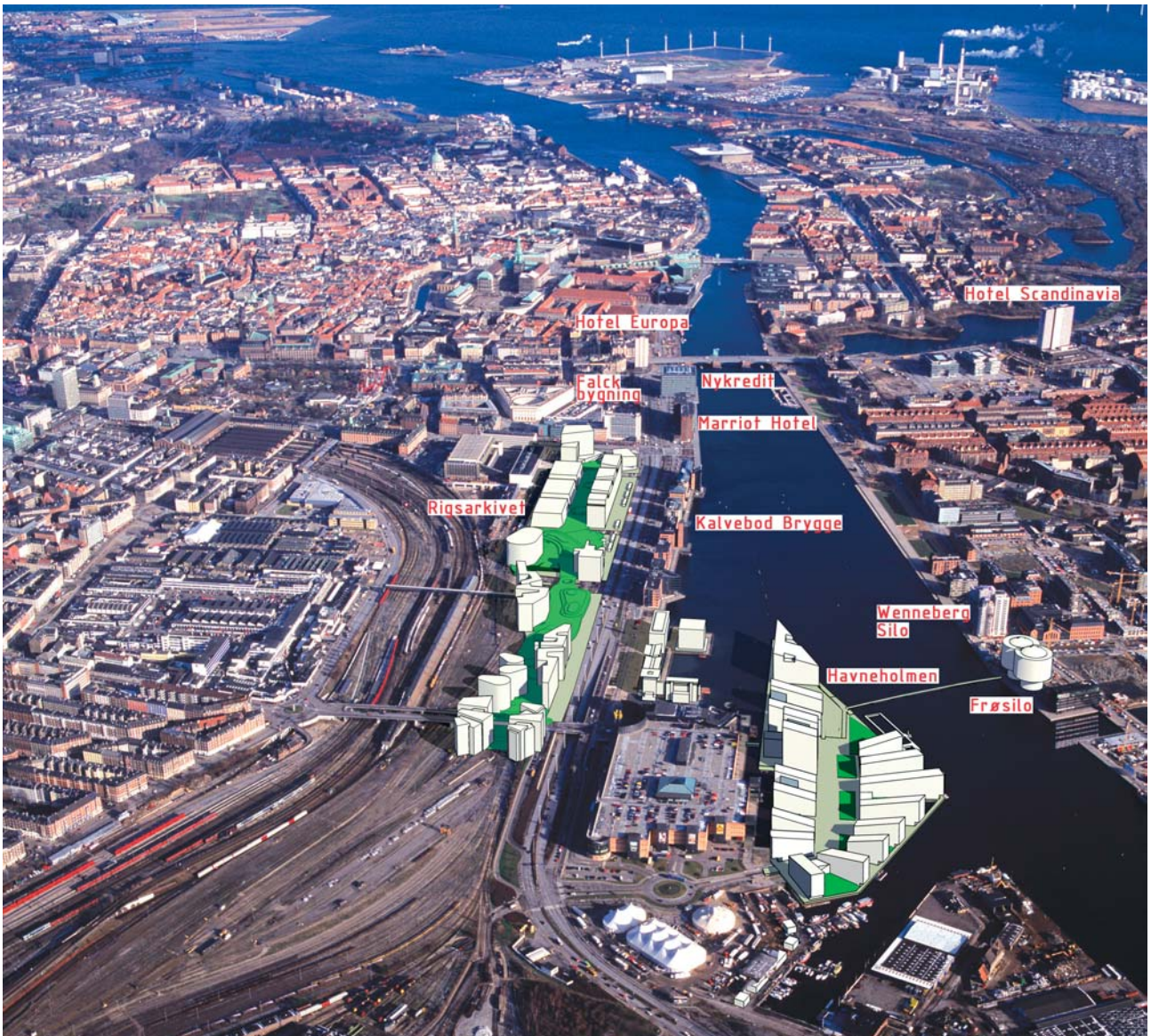
Lokalplanområdet ligger i en del af byen, der præges af store vidder og store bygningsvolumener, herunder flere bygninger af anselig højde. På luftfotoet, taget fra syd, er markeret områdets høje bygninger.
